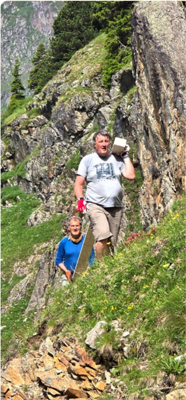
Einblicke in die Arbeitsausfahrt zur Rüsselsheimer Hütte 2025: Transport der neuen Brückenbalken. Mehr dazu ab Seite 10.
